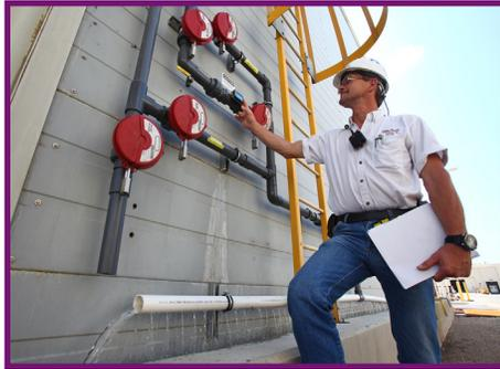
Cette usine a aussi implanté un système qui récupère et réutilise le condensat produit par les régulateurs de température et d'humidité des procédés de fabrication et autres. Selon des compteurs installés en février 2010, ce nouveau système a réutilisé plus de 800 000 gallons d'eau pendant une période de sept mois.
